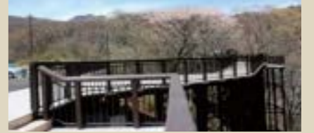
展望台の改修
