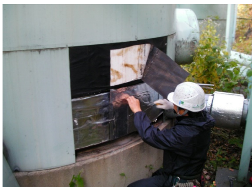
保温材取り外し状況
