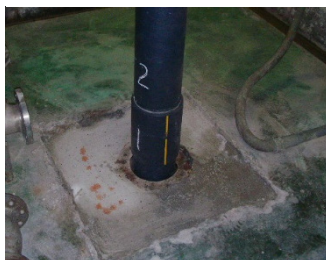
ケーシング管挿入状況
