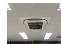
換気設備の導入
