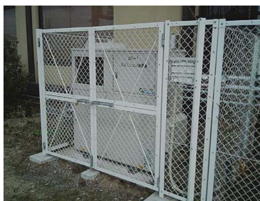
〈ガスエンジン発電機の外観〉
