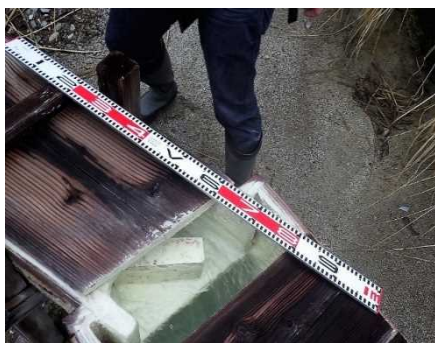
図 8 樋の中に設置されたレンガ
