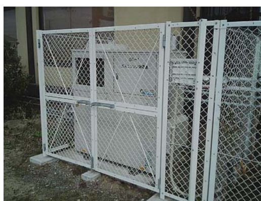
〈ガスエンジン発電機の外観〉
