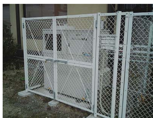
〈ガスエンジン発電機の外観〉
