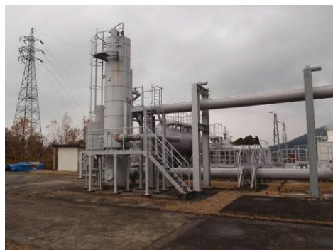
写真3 気水分離器
