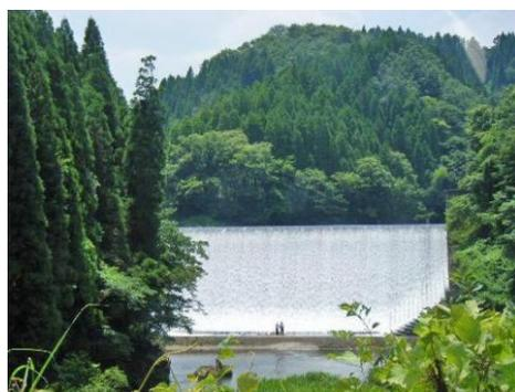
▲白水（はくすい）ダム（白水溜池堰堤水利施設） / 1999年（平成11年）に国の重要文化財に指定された近代文化遺産。竹田市と豊後大野市緒方地区を流れる富士緒井路（ふじおいろ）の水量不足を解消するために設けられた堰堤。大分県の農業土木技師であった小野安夫の設計・監督により、1934年（昭和9年）4月に着工し、1938年（昭和13年）3月に竣工した。堰堤の転波列を越えて流れる水流や左右両端の流路が作り出す水流の美しさは高く評価されており、日本一美しいダムと評する研究者もいる。
