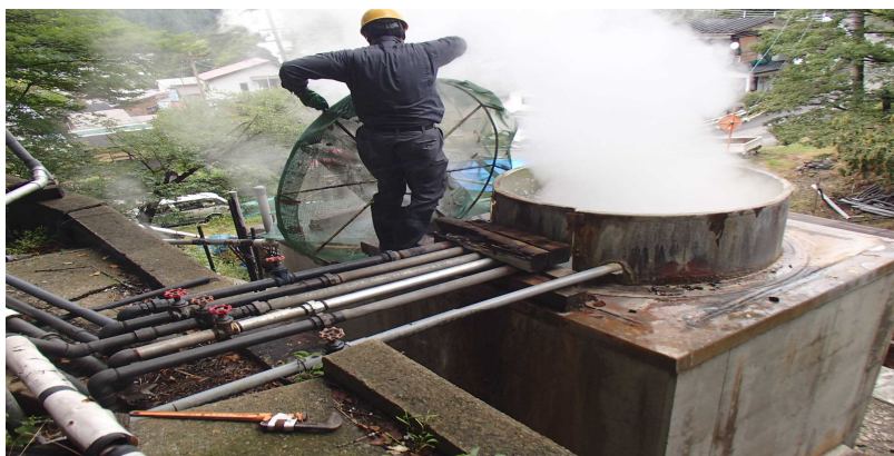
【保守点検の様子】
