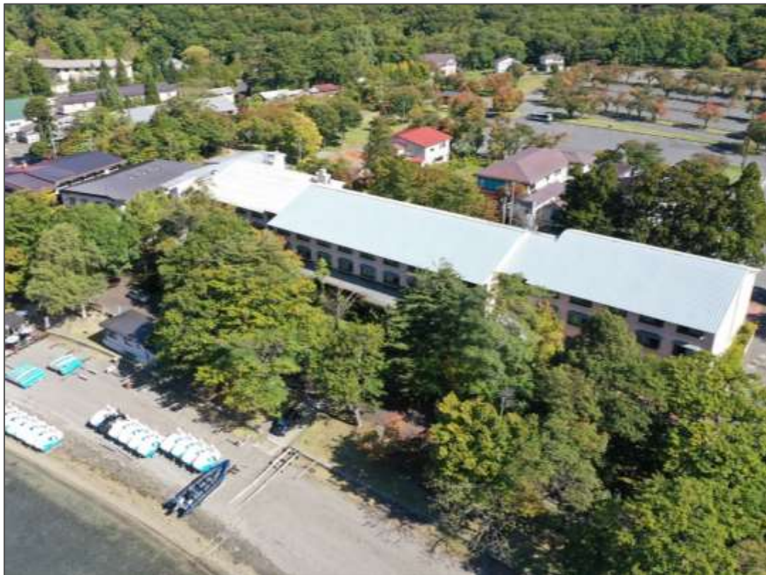
十和田観光ホテルの全景（廃屋撤去前）
