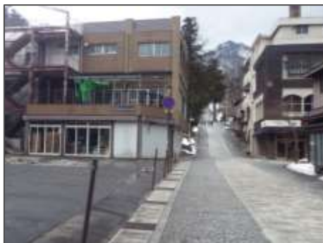
廃屋となっていた元宿泊施設
