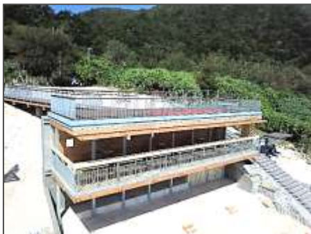
ニシバマテラスの全景写真
