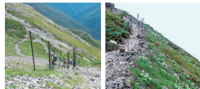
悪沢岳に設置された防鹿柵
