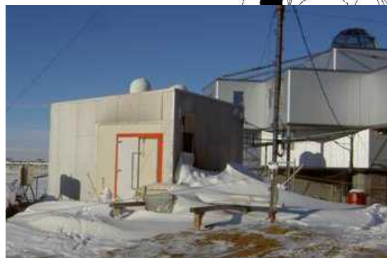
木工所(旧焼却炉棟)
