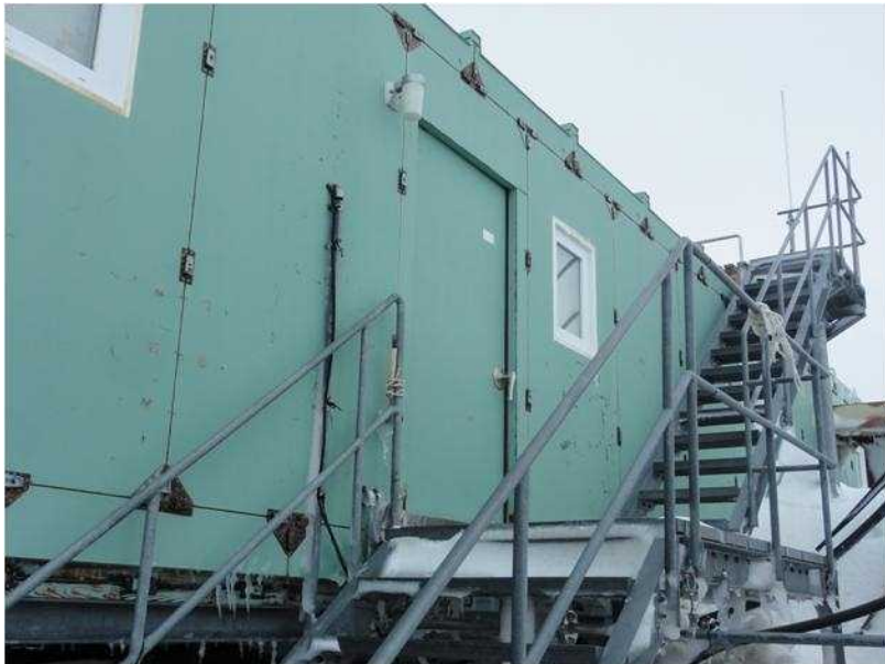
衛星受信棟扉改修
