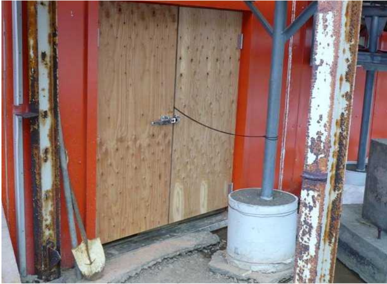
発電棟扉改修
