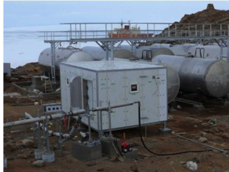
見晴らしポンプ小屋窓交換
