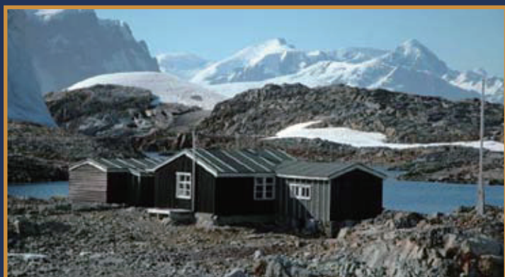
北側から見た小屋。建物の構造がわかる。
