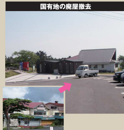
国有地の廃屋撤去
