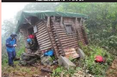
退避施設等の倒壊
