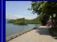
歩道(ウッドデッキ)
