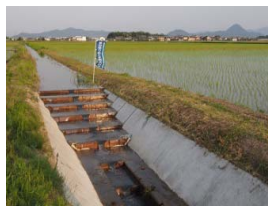
排水路堰上式魚道
