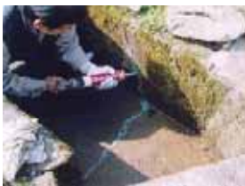
水路のひび割れ補修
