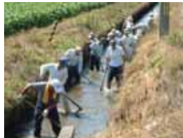
水路の泥上げ
