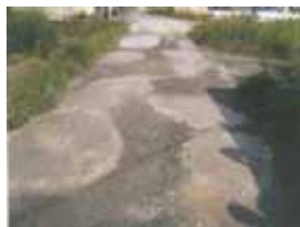
農道の窪みの補修
