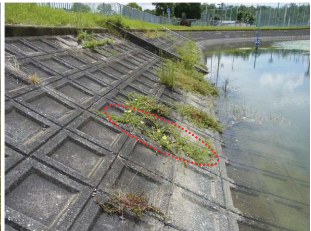
図 1-1-42 逆池の東側のコンクリート護岸の隙間に生育するオオバナミズキンバイ (2014. 8. 20)
