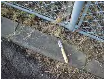
コンクリート縁石と土壌との境界
