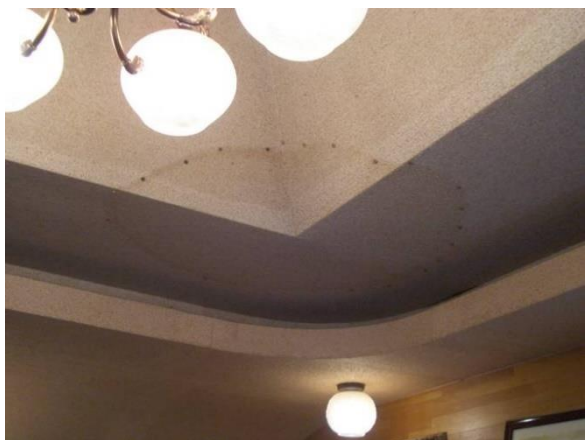
写真7 アライグマに侵入された家屋の汚損状況 屋根裏にたまった糞尿による汚損が発生しています 写真提供：兵庫県森林動物研究センター
