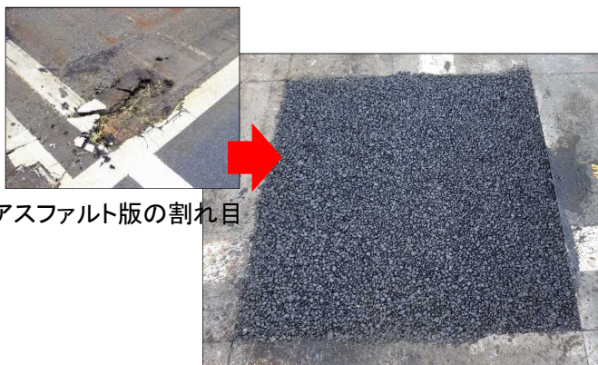
ヒアリ定着防止対策緊急工事① (アスファルト版の復旧)
