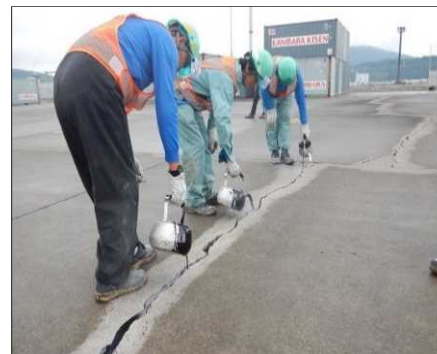
ヒアリ定着防止対策緊急工事② (加熱式充填材の注入)
