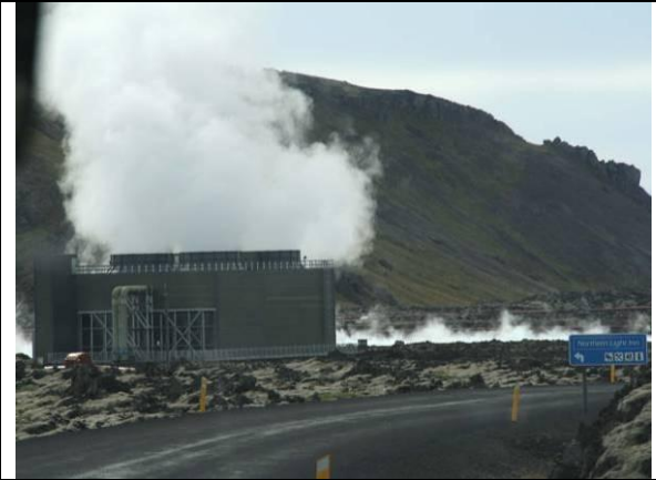
冷却塔の状況。周辺に熱水が排水されているため、あちらこちらから水蒸気が立ち上っている。
