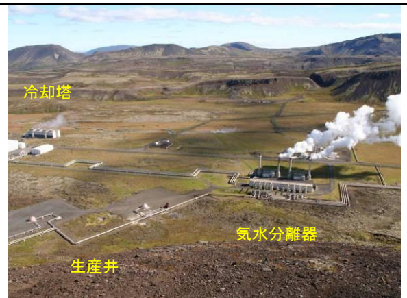
発電所のパノラマ写真② 左手が発電所本館や冷却塔、右手が気水分離器。冷却塔よりも気水分離器からの水蒸気が目立つ。
