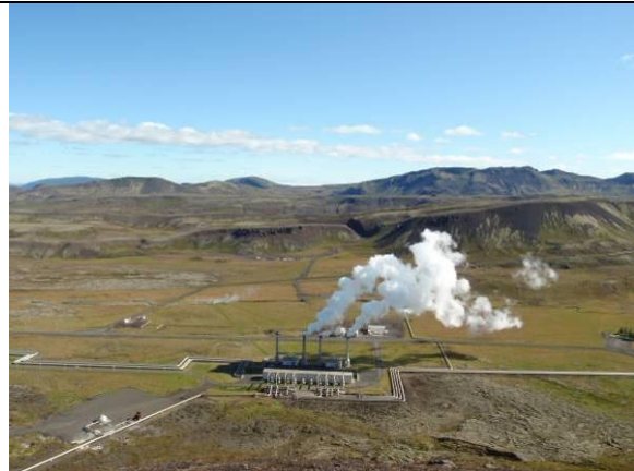
発電所のパノラマ写真③ 気水分離器の状況。各施設ともにコンパクトにまとめられている。
