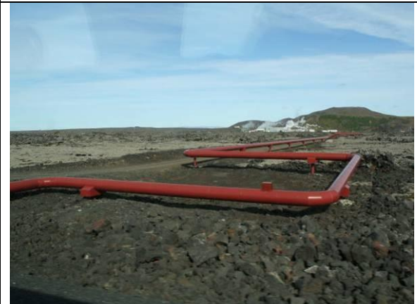
パイプラインの状況。溶岩台地に敷設されている。
