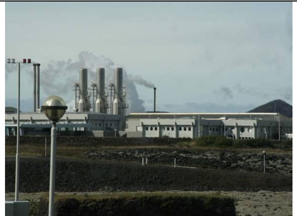
発電所本館の状況。
