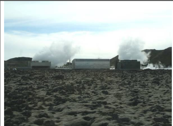
発電所本館と冷却塔の状況。溶岩台地に建設された発電所である。
