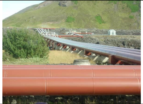
パイプラインの状況。
