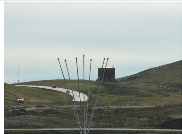
近隣集落へ熱水を送るための中継となる台地上の熱水タンク。ここまでは圧力をかけて熱水が送られ、ここからは自然流下で集落へ送られる。
