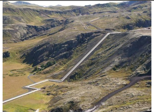
発電所のパノラマ写真④ 熱水輸送用のパイプライン。台地の上まで圧力で送られた後、熱水タンクに集められ、その後、標高差を利用した自然流下でレイキャビク市へ送られる。
