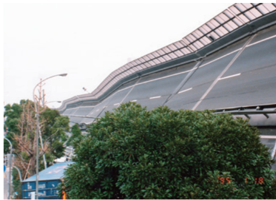
阪神・淡路大震災での深江本町阪神高速倒壊 (写真提供：神戸市)
