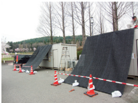
遮光ネットを設置
