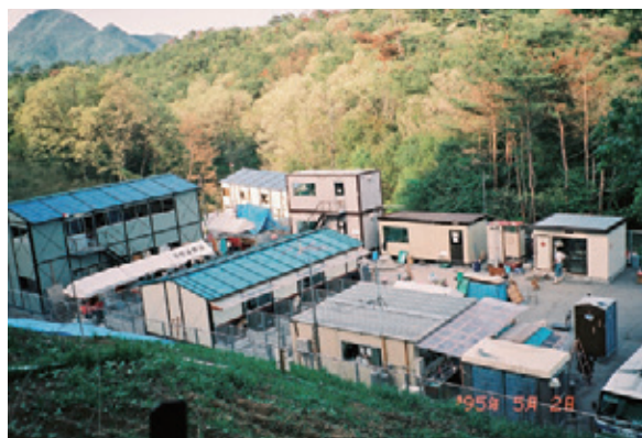
改修後の外観
