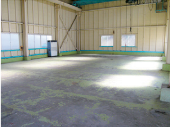
空き工場の状況 (既存の業務用エアコン2台を活用)
