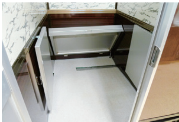
犬舎：内部（床面に排水溝を整備）
