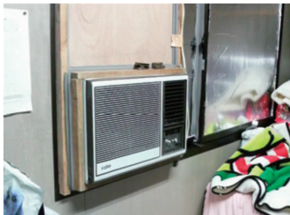
エアコンを設置
