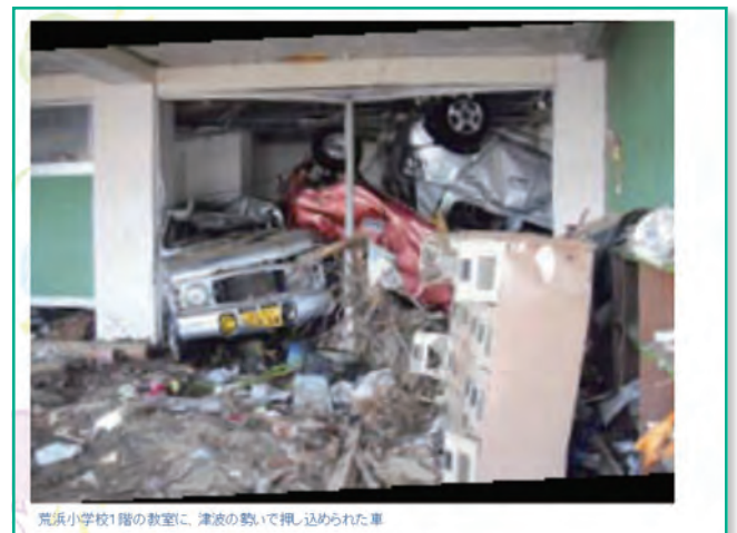
荒浜小学校1階の教室に、津波の勢いで押し込められた車
