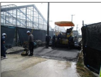
施設の長寿命化活動 (アスファルト舗装等)
