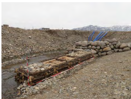
図Ⅱ-3-40. 粗朶沈床図
