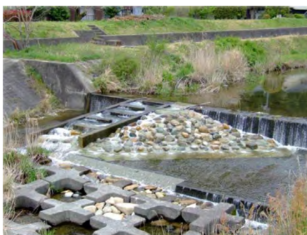
図Ⅱ-3-38. 山口県樫野川に設置された「水辺の小わざ魚道（側面設置型）」 浜野龍夫氏撮影
