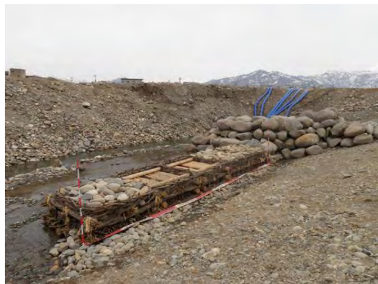
図Ⅱ-3-40. 粗朶沈床図
