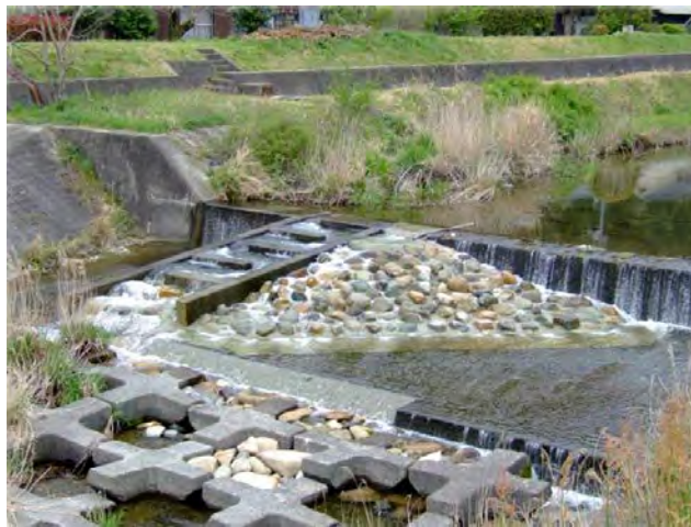
図Ⅱ-3-38. 山口県樺野川に設置された「水辺の小わざ魚道（側面設置型）」 浜野龍夫氏撮影
