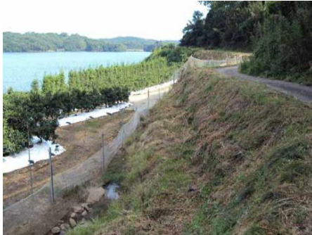
（進入防止柵及び周辺の草刈り）
