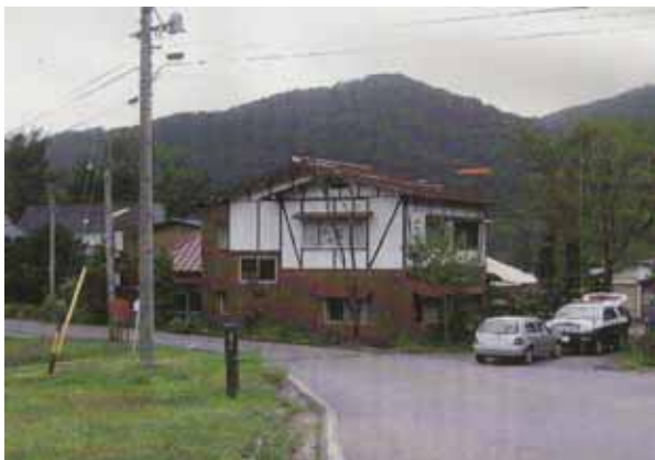
参考写真 クマによる窓ガラスは損などの被害を受けた民宿（中央）。屋根のペンキの塗り替えがクマを誘引した可能性がある。（長野県白馬村；長野県資料より）
