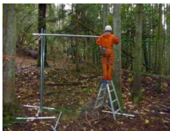
写真 3-2 大型捕獲柵の設置作業
