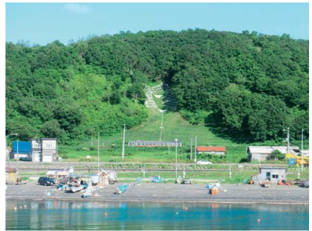
土砂崩壊防備保安林(北海道増毛町)
