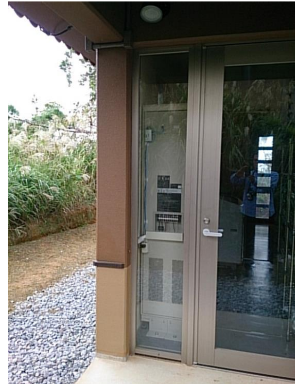
定置用蓄電池(ESS)@House 204
