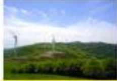
⑳ グリーンパークくずまき風力発電所 ×12 21,000kW (1,750kW × 12基) ※上野川工業
