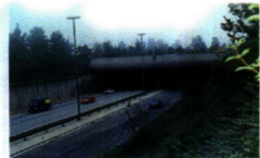
道路に蓋をするように人工地盤をつくり表土をかぶせたり、生きものの通るトンネルをつくり自然の連続性を取り戻す。
