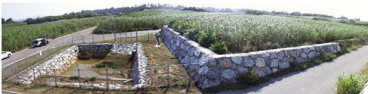
勾配修正(ほ場の下流側を盛ることで勾配を抑制している)
