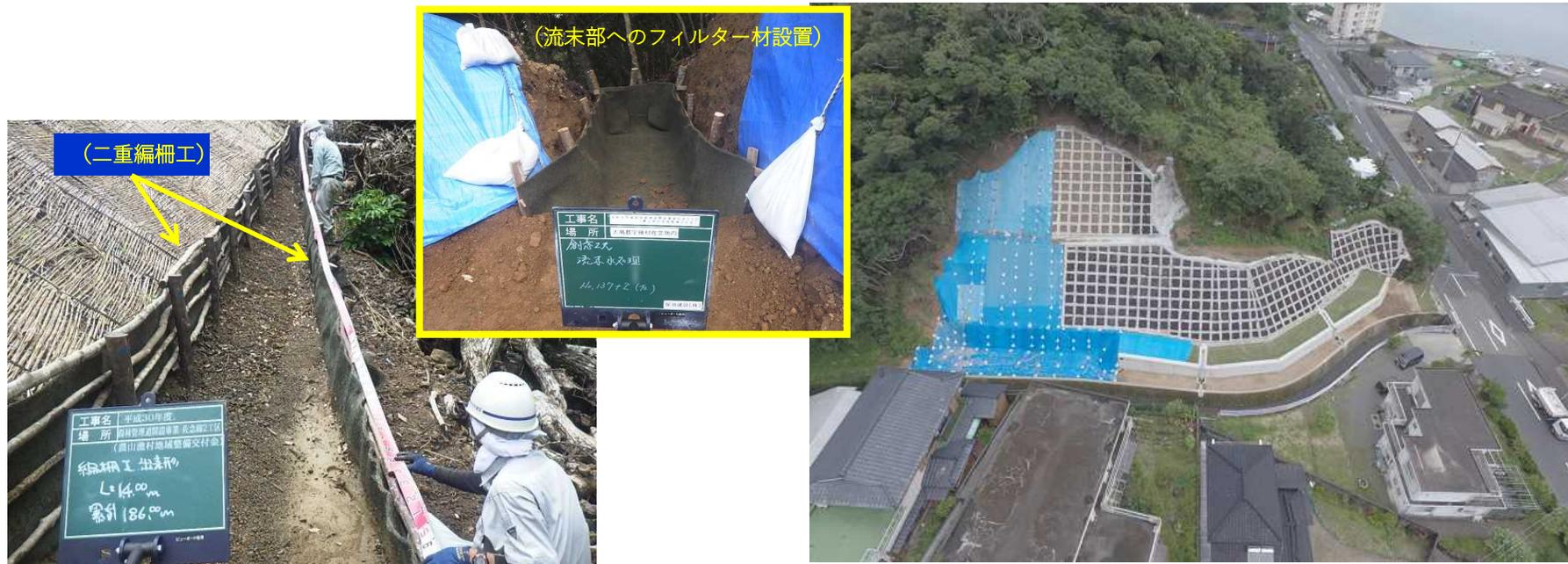
写真4 編柵工・フィルター材設置
