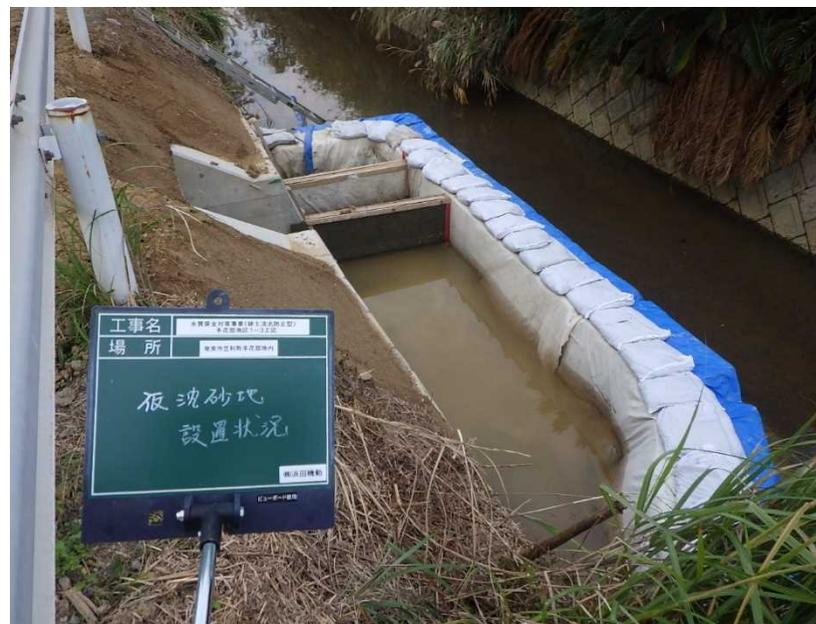
写真7 仮沈砂池設置状況
