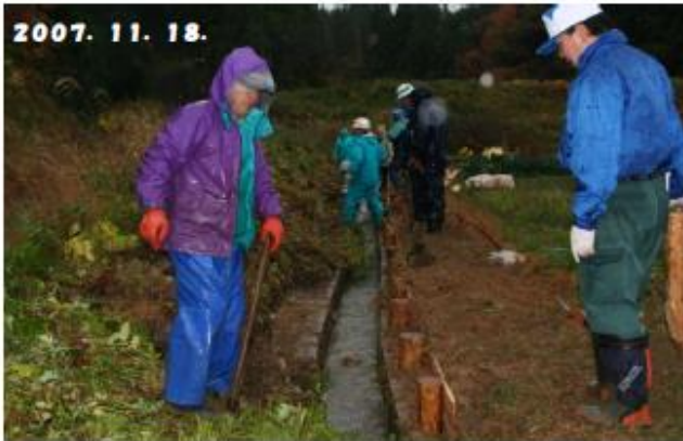
三浦先生の指導の下で雨の中で環境整備開始！ (護岸の嵩(かさ)上げ作業)
