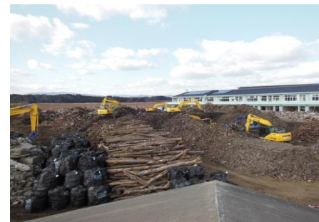
撤去前(平成26年1月)
