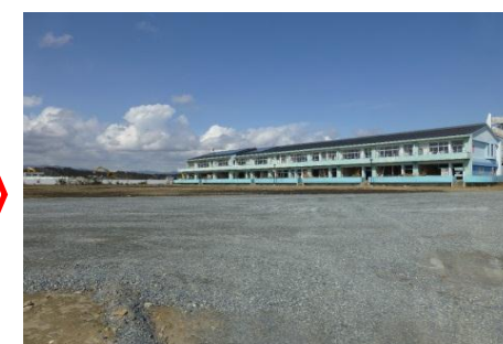
撤去後(平成27年3月)
