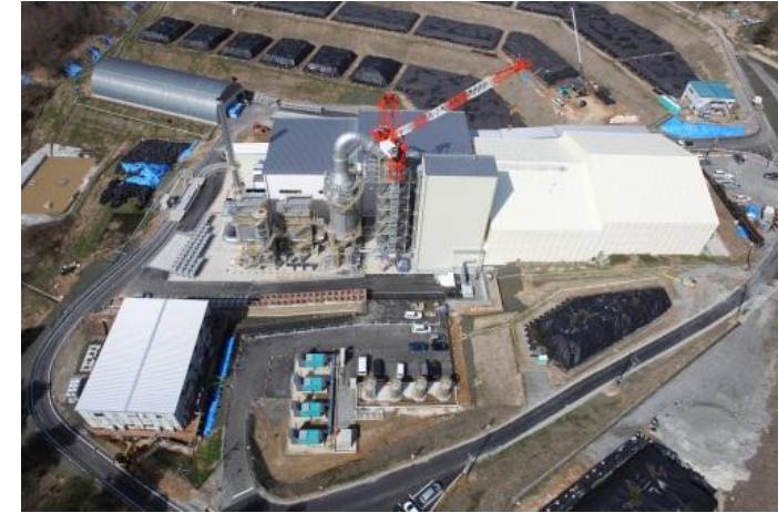
葛尾村仮設焼却施設
