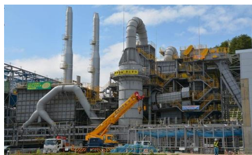
飯舘村蕨平地区の仮設焼却施設 (平成27年10月)
