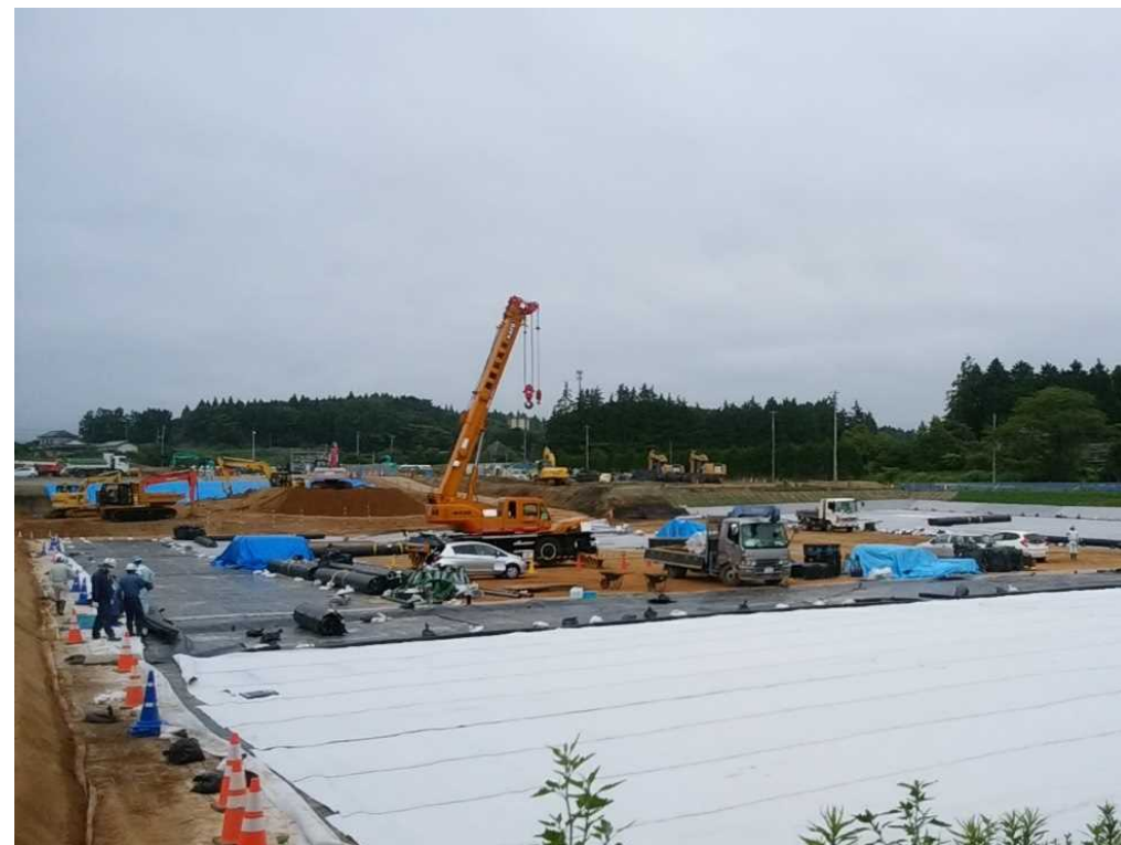
土壌貯蔵施設予定地における遮水工
