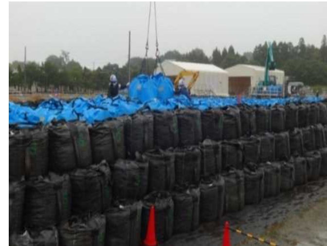
保管場への定置作業
