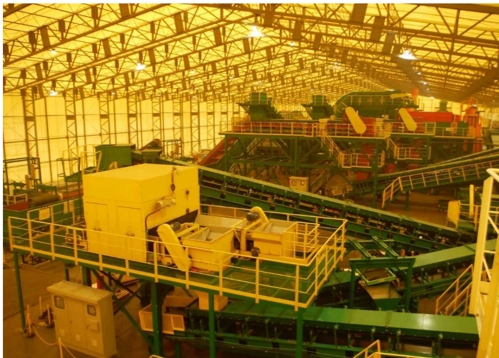
受入・分別施設(受入・分別棟内部)
