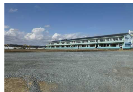
撤去後(平成27年3月)
