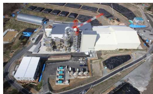
葛尾村の仮設焼却施設 (平成27年4月)
