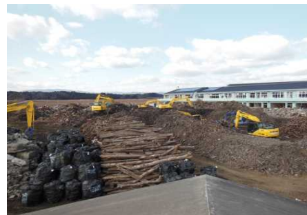
撤去前(平成26年1月)
