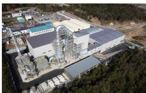
南相馬市の仮設焼却施設 (平成27年3月)
