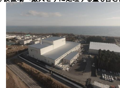
大熊町の仮設焼却施設
