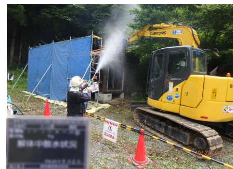
被災家屋等の解体の様子
