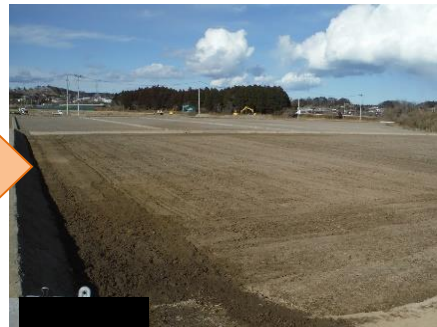
整地（均平化）終了時
