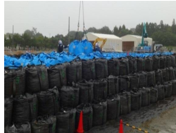
保管場への定置作業
