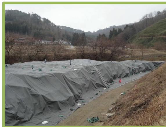
雨水浸入防止の措置の例
