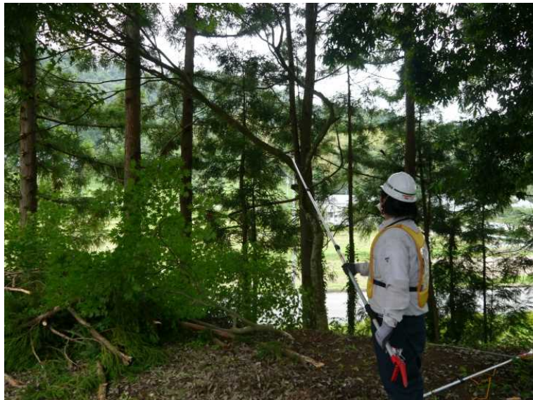
図 2-72 森林の除染の例（枝葉の除去）
