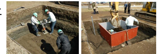
試験施工の様子
