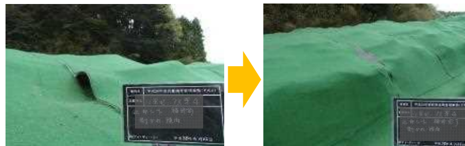
折れ曲がり部
