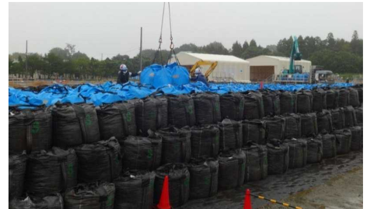
保管場への定置作業
