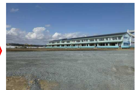
撤去後(平成27年3月)
