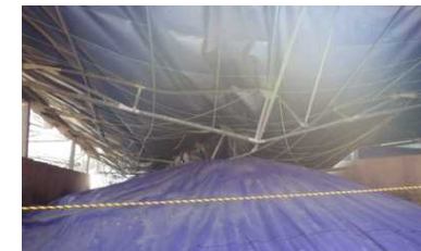
【大雪によりテントの屋根が破損した様子】
