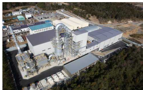
南相馬市の仮設焼却施設 (平成27年3月)
