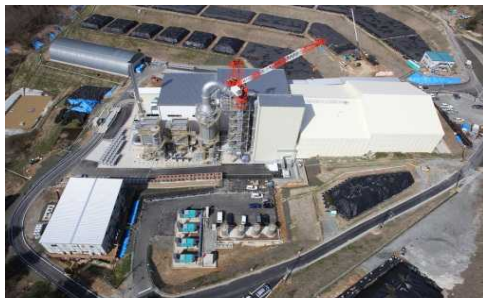
葛尾村の仮設焼却施設 (平成27年4月)
