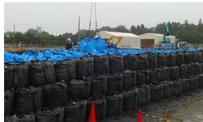
保管場への定置作業
